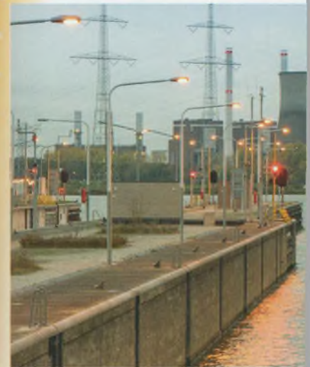
Zicht op Clauscentrale vanaf sluis Linne
