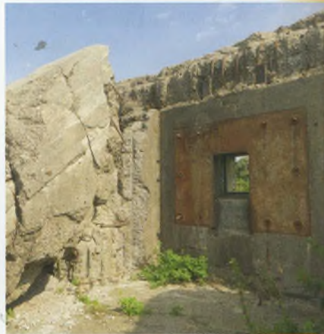
Kazemat bij de brug naar Gennep
